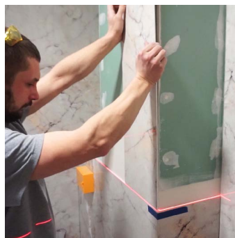
Rys 15. Montaż płyt na narożniku wypukłym
