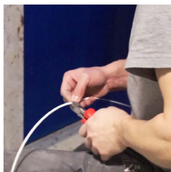
Rys 13. Pióro docinamy szczypcami tnącymi
