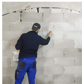
Rys 4. Gruntowanie ściany
