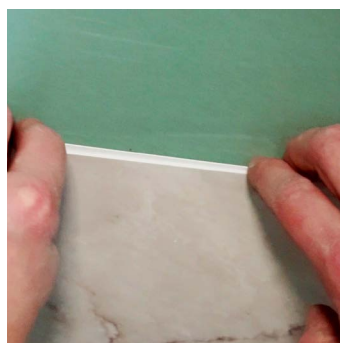
Rys 12. Montaż pióra
