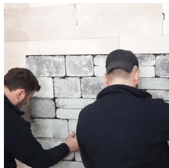
Rys 1. Płyty można montować na różnych rodzajach podłoży, również bezpośrednio na stare płytki ceramiczne
