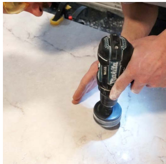
Rys 8. Wycinanie otworów wiertłem koronowym
